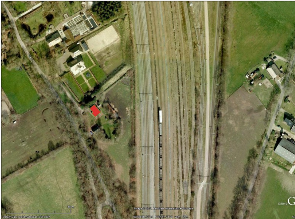
Figuur 24: Cluster 8 Viaductweg 56
