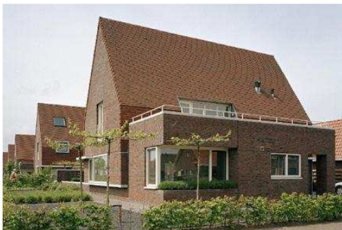
Voorbeeld van een steile kap en een gedetailleerde hoekoplossing
