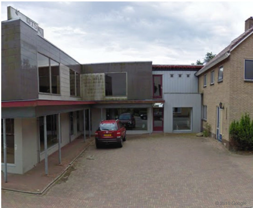
Foto 1: te slopen bedrijfspand Provincialeweg nr. 56 en 58
