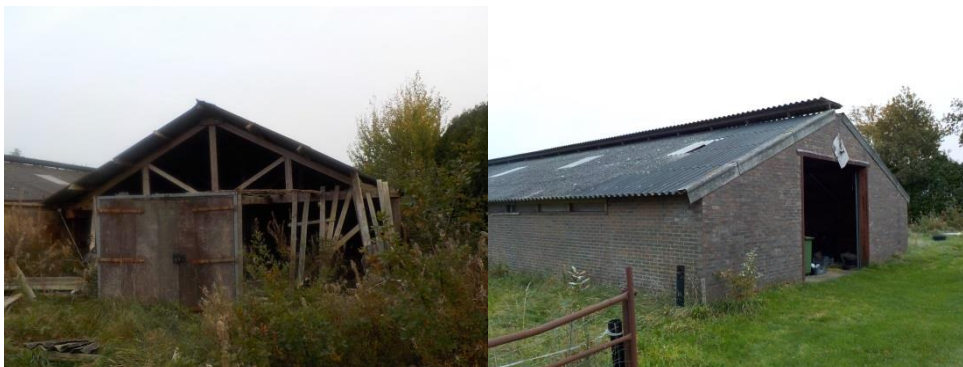
Foto 2 De schuren achter de boerderij met links de schuur met houten skelet en rechts het stalen skelet met stenen muren
