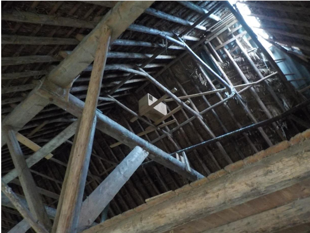
Foto 6 Kerkuil broedkast in de boerderij aan de Provincialeweg 67 te Opende
