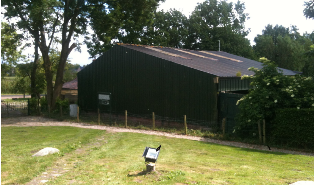
zicht vanaf de historische begraafplaats op de bij de woning geplaatste schuur
