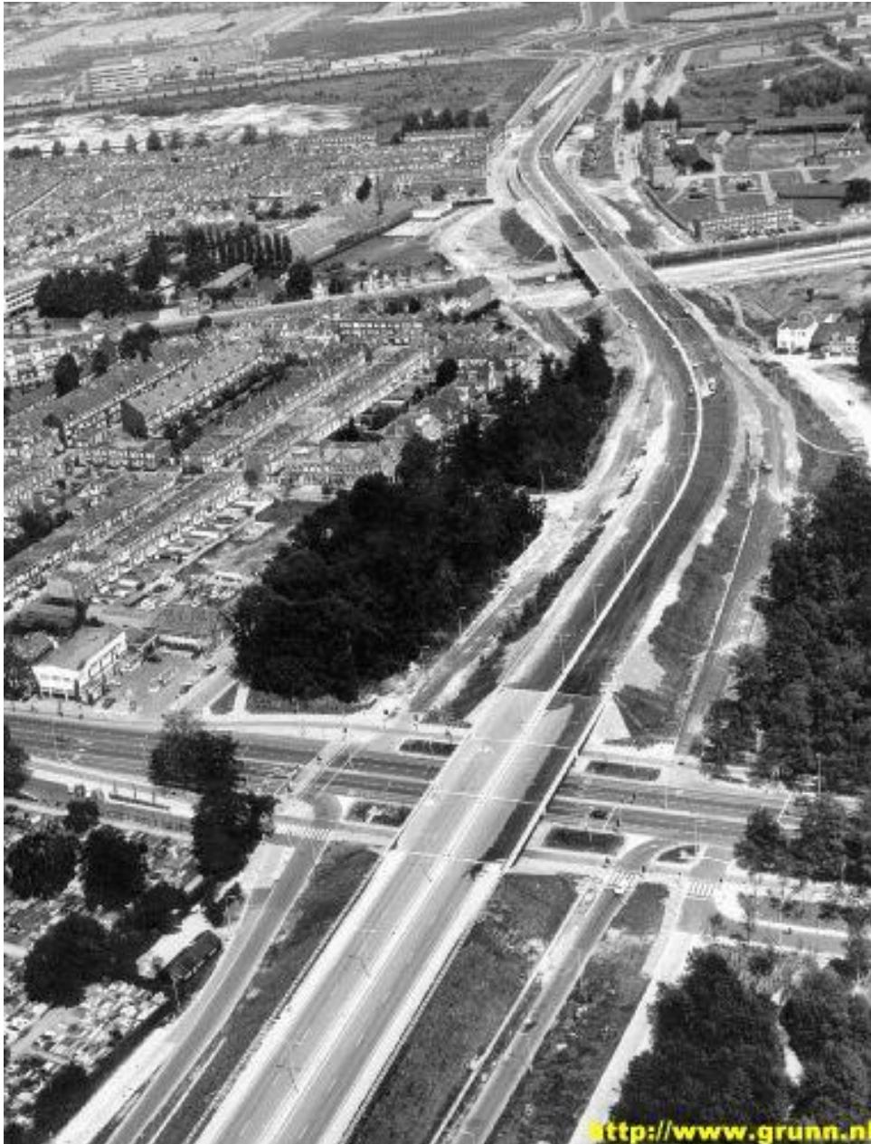
Aanleg Weg der Verenigde Naties
