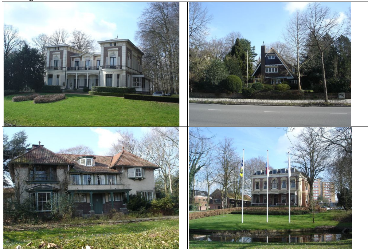
Villabebouwing aan de Verlengde Hereweg
