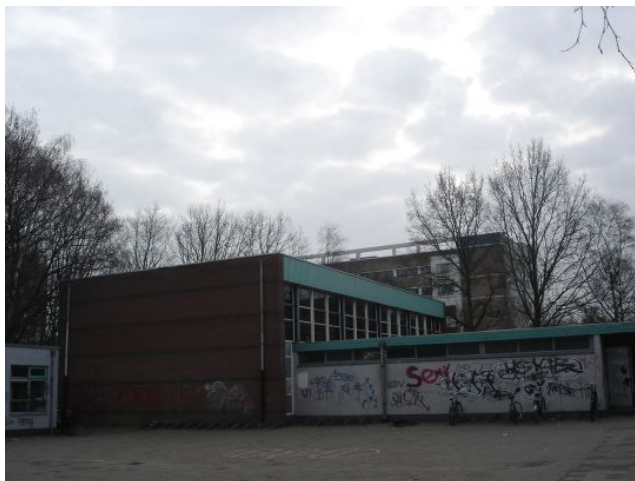
Bestaande Haydnschool op de hoek van de Helperbrink en de Haydnlaan
