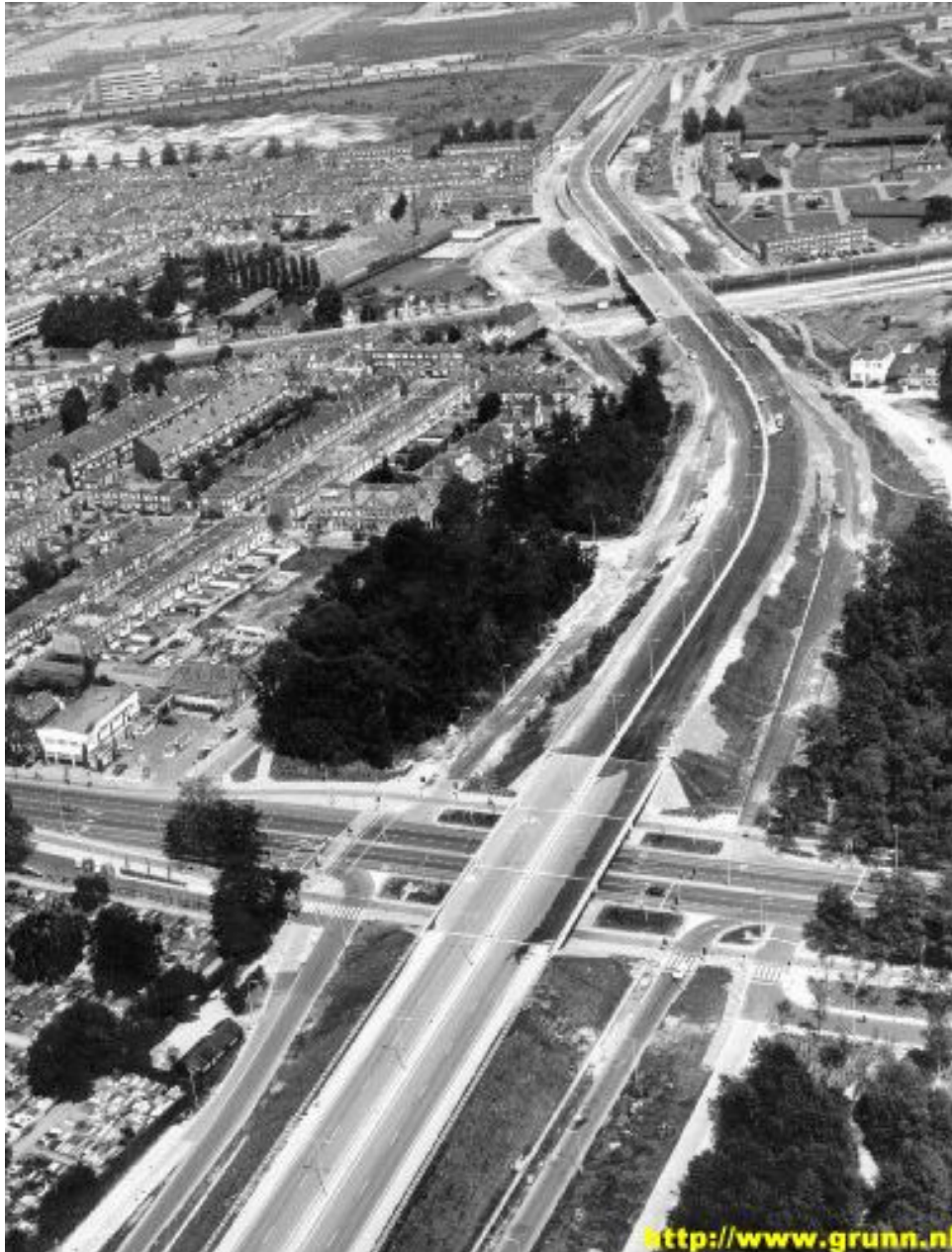
Aanleg Weg der Verenigde Naties
