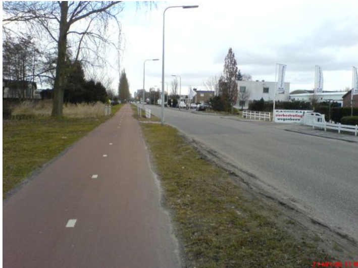
Peizerweg met vrijligging fietspad en straatverlichting
