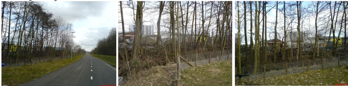
Achterkantsituaties vanaf de HOV/as/busbaan
