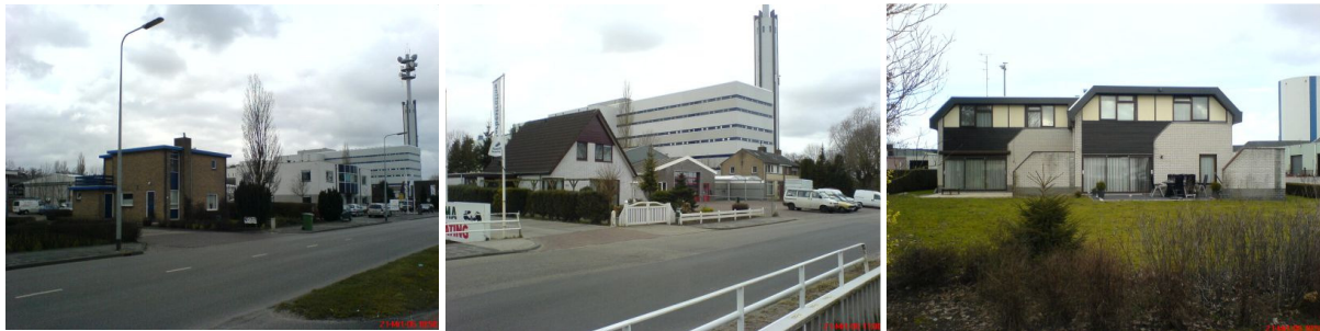
Bestaande bedrijfswoningen aan de Peizerweg
