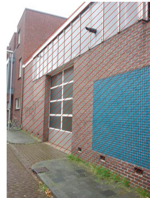
Barestraat / te slopen bouwwerk
