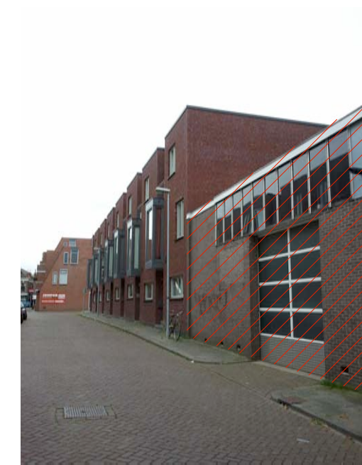
Barestraat / te slopen bouwwerk
