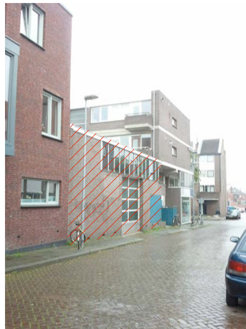
Barestraat / te slopen bouwwerk
