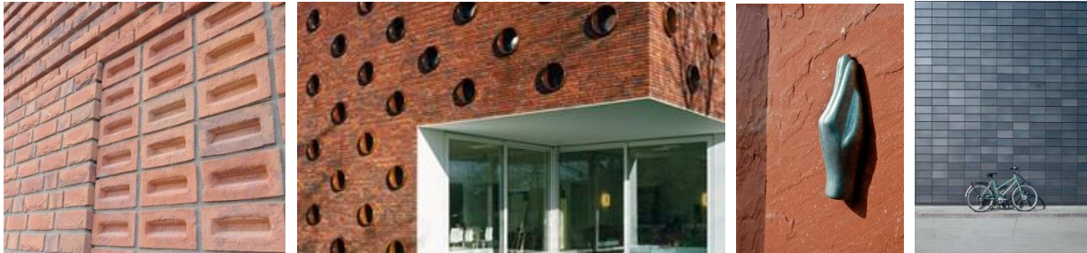
Gevelmaterialen metselwerk: reliëf, verband, textuur
