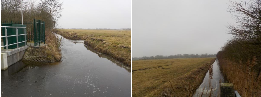
Foto 1 Het tracé gaat aan de zuidzijde langs het Edonbos en een brede sloot richting oosten.
