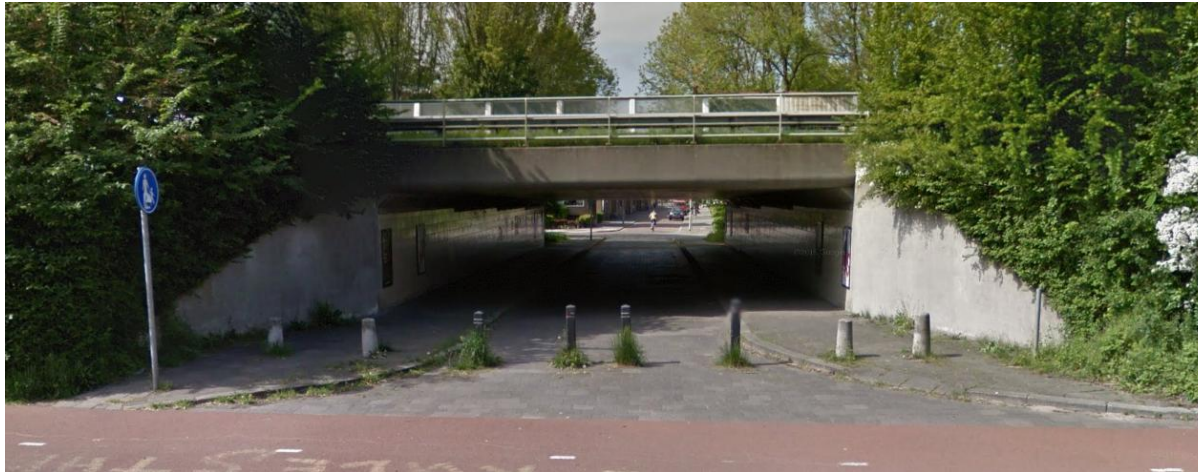
Figuur 1: Huidige fietstunnel Papiermolenlaan (Bron:Google Street View)
