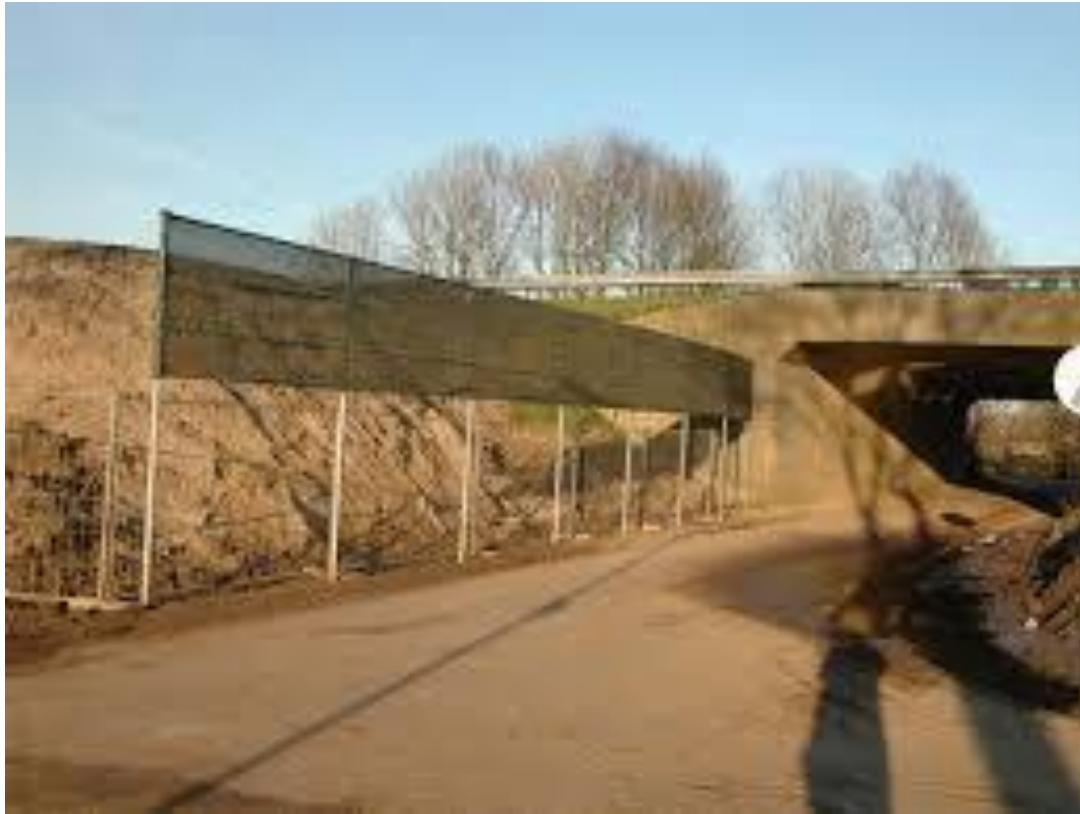
Figuur 11: Speciaal voor vleermuizen aangelegde schermen die als 'echobaken' dienen.
