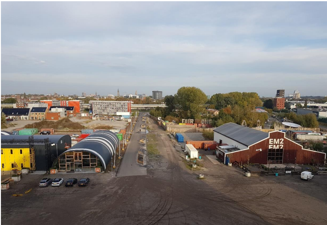
Zicht vanaf het Zeefgebouw richting binnenstad
