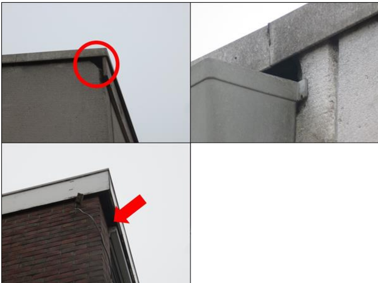
Figuur 2.2. potentiële verblijfplaatsen voor de gierzwaluw en de huismus.
