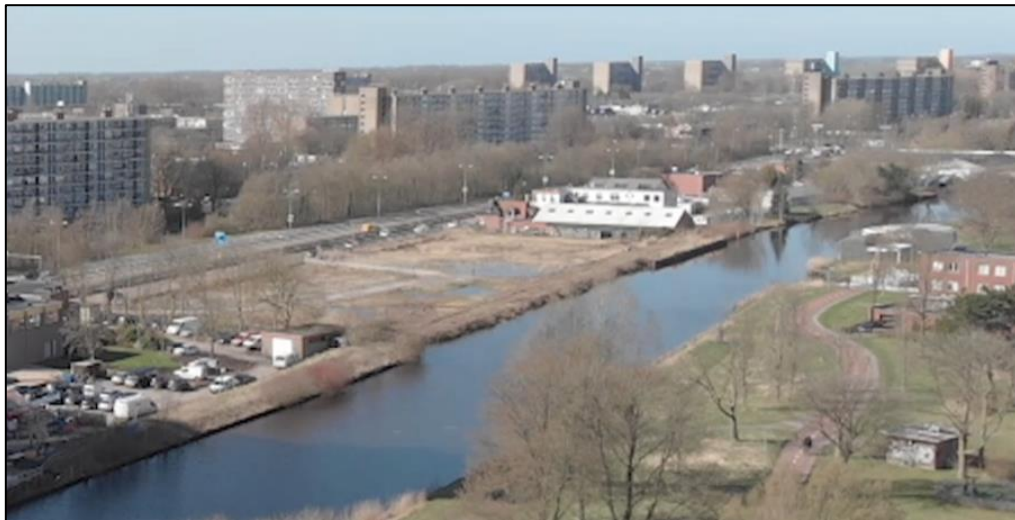
Figuur 1: Bestaande situatie
