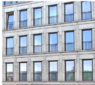
Gevel met openingen in natuursteen
