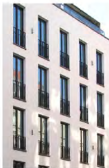
Gevel met openingen in pleisterwerk
