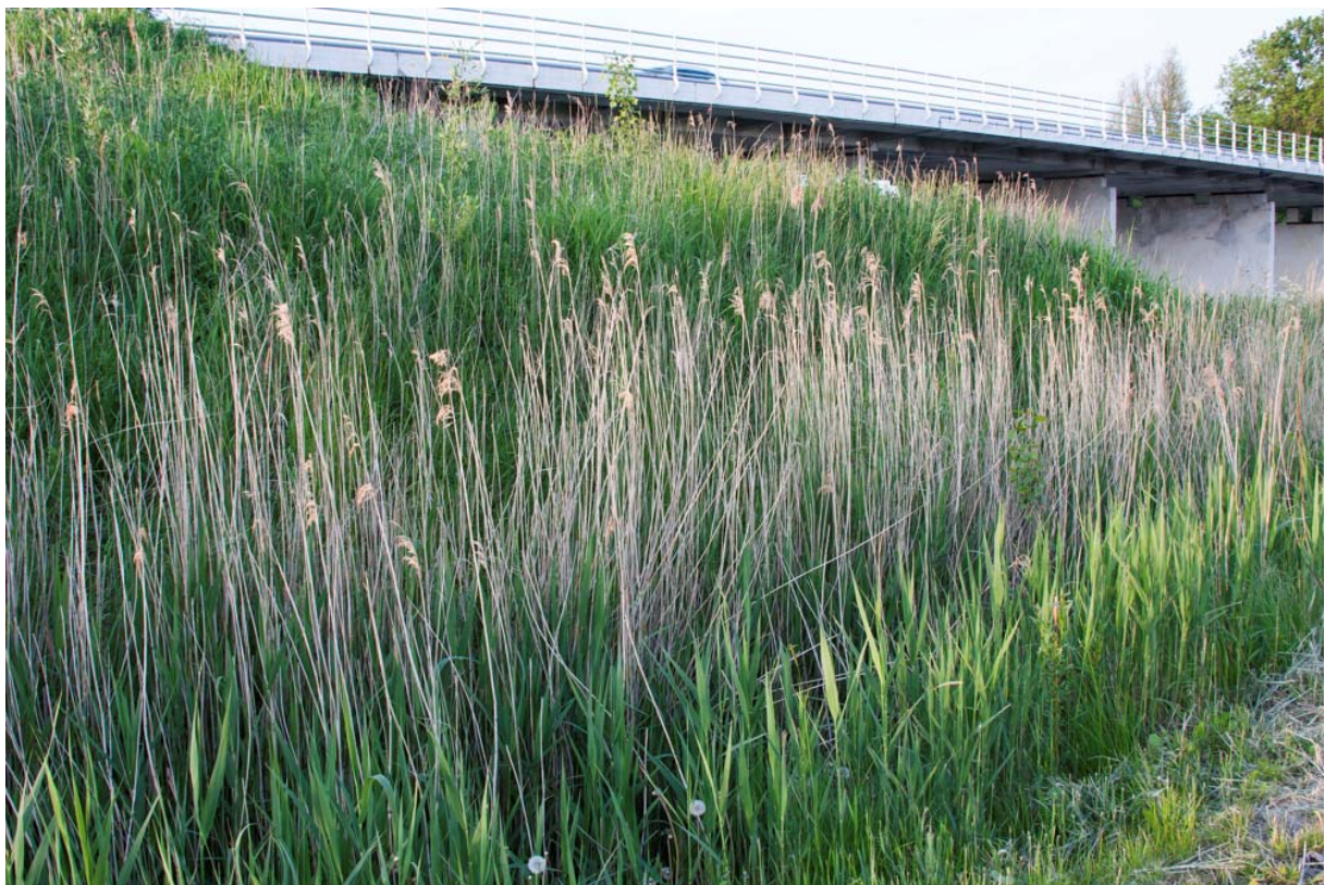
Foto 1. Viaduct bij Nieuwklap met ruige begroeiing.
