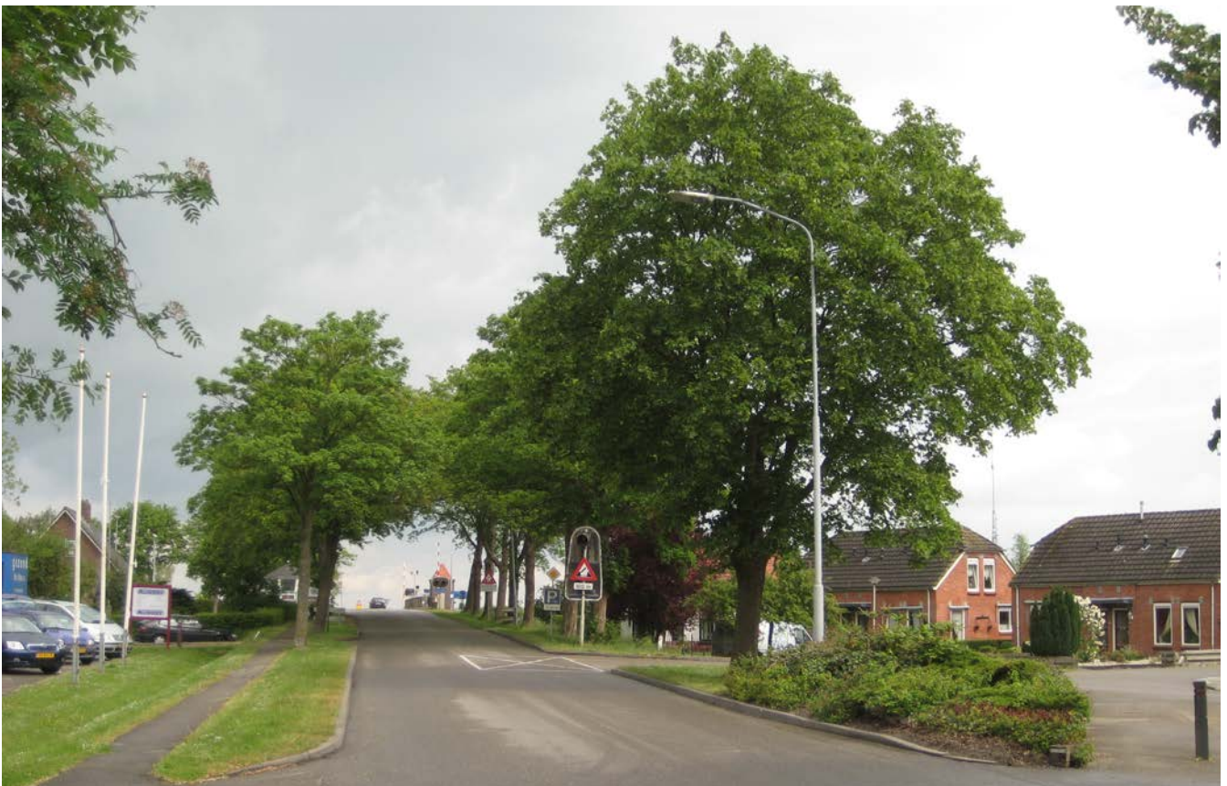
Foto 3: Aan de zuidkant van de brug, aan weerszijden van de Burgemeester van Barneveldweg staan eveneens esdoorns. De esdoorns verkeren niet allemaal in een even goede conditie.
