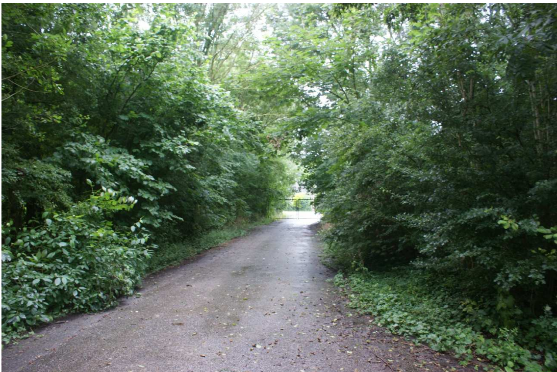
Foto. 6 Met asfaltverharde infrastructuur op noordelijk terreindeel
