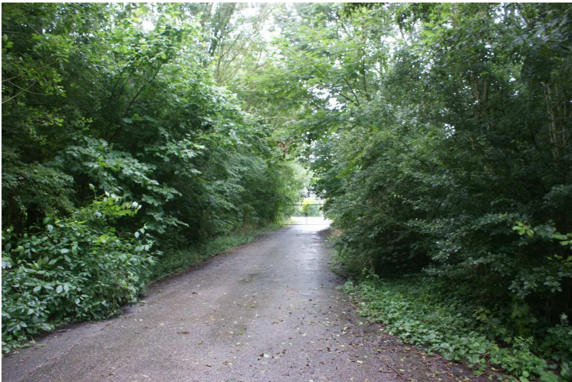
Fig. 2.7 Met asfaltverharde infrastructuur op noordelijk terreindeel
