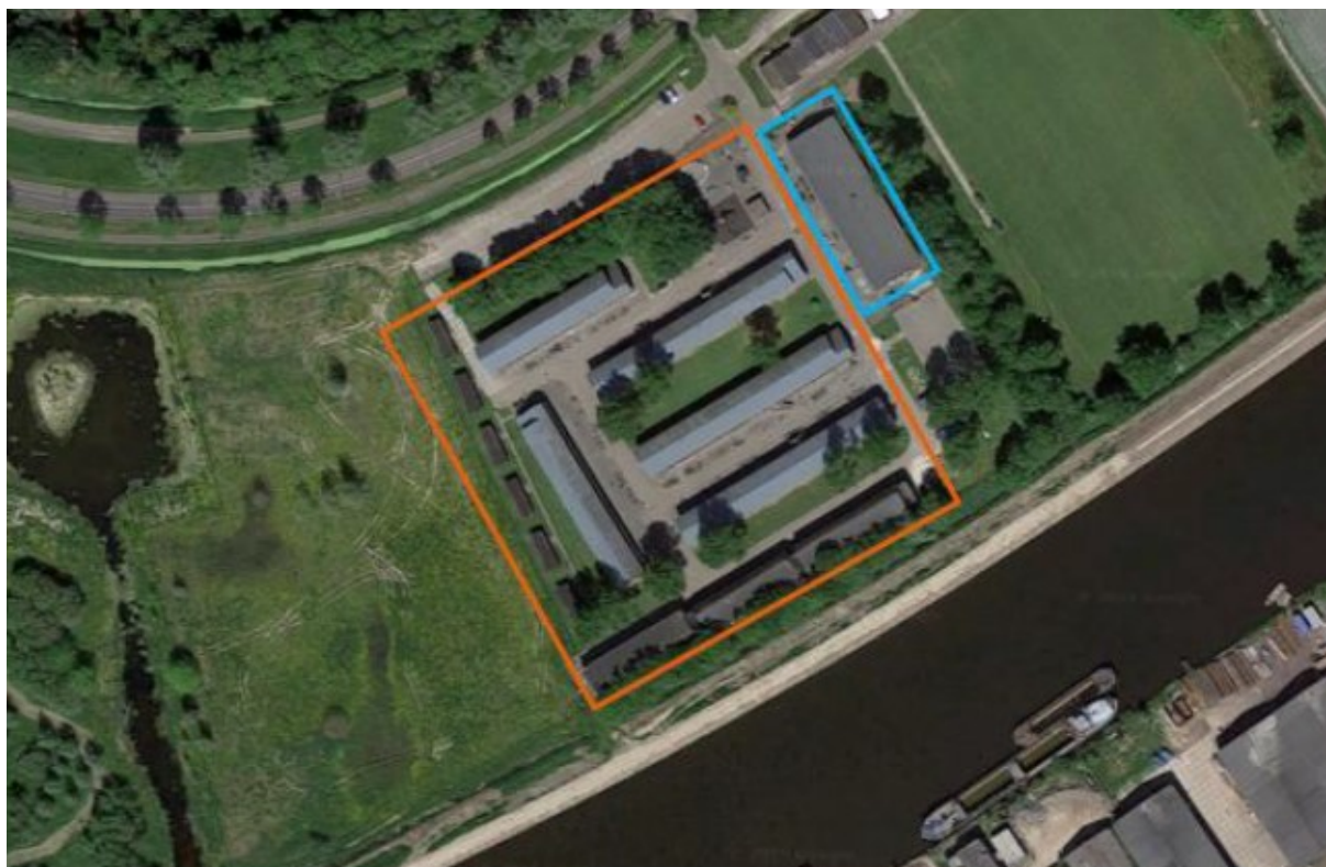
Figuur 1. De bebouwing welke gesloopt wordt (oranje omlijnd) en bebouwing waar de tijdelijke kasten geplaatst worden (blauw omlijnd)
