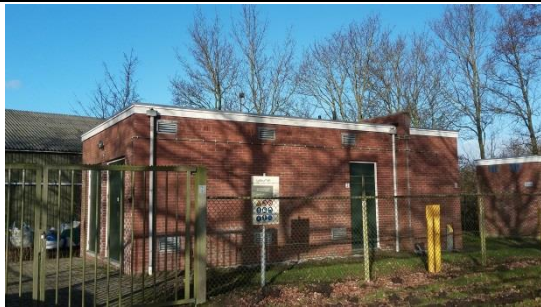
Gasontvangstation met potentiële verblijfplaatsen voor vleermuizen
