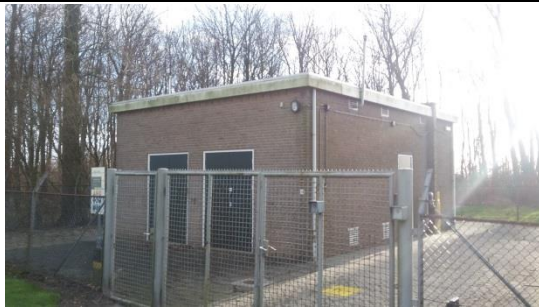
Gasontvangstation met potentiële verblijfplaatsen voor vleermuizen
