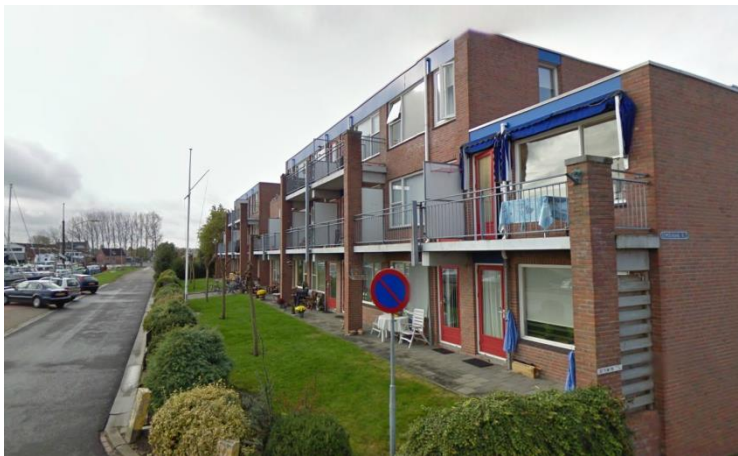
Eemskanaal Noordzijde, westrichting
