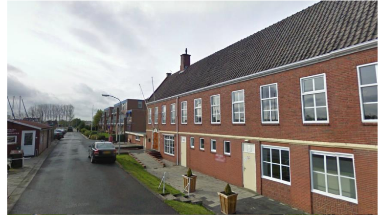
Eemskanaal Noordzijde, westrichting
