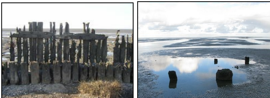
Figuur 8. Links een palenscherp bij Moddergat (bron: Google Maps). Rechts de resten van palen van een baak op de Engelsmanplaat (bron: www.verdrongengeschiedenis.nl )
