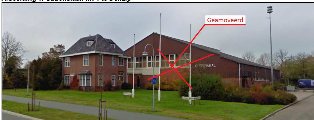
Afbeelding 1: Ubbenslaan nr. 1 te Delfzijl
