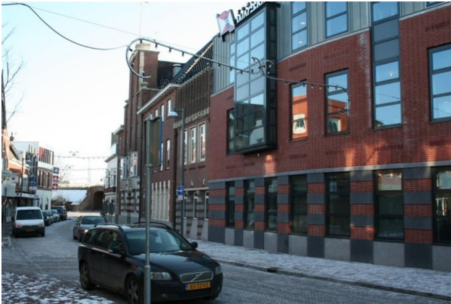
Figuur 8 Complex met een sterke nadere geleding Figuur 9 De ritmiek van de breedte van de geveldelen en de verticaal gerichte gevelopeningen in de voorgevel zorgen voor samenhang met naastgelegen panden, een goede verhouding tussen open- en geslotenheid van het gebouw en een herkenbare schaal. De plastic van de gevel, de diepteligging van de ramen en erkers en de herhaling van 'de pilasters' zorgen voor een interessante gevel.
