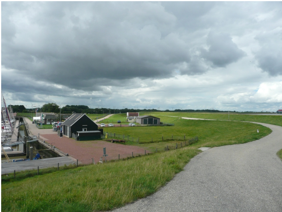
Foto 3.4 Aanzicht TOP Termunterzijl in zuidwestelijke richting met links de winkel, rechts de loods en daartussen het grasland en het parkeerterrein
