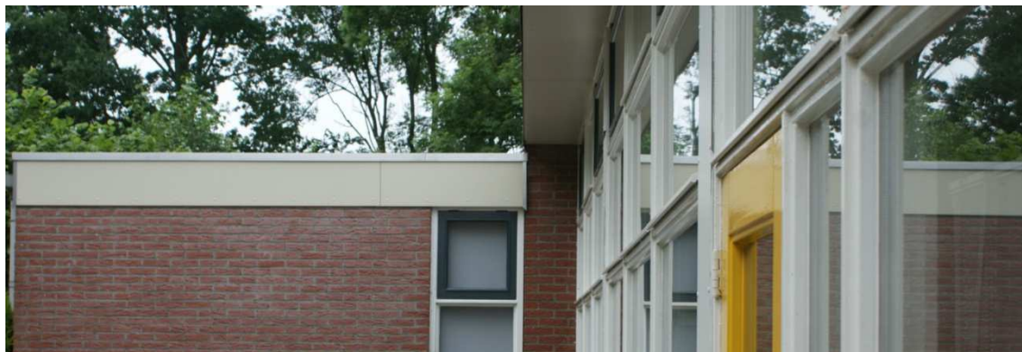
Figuur 5.2 Afgewerkte boeiborden aan zuidoostzijde clubgebouw
