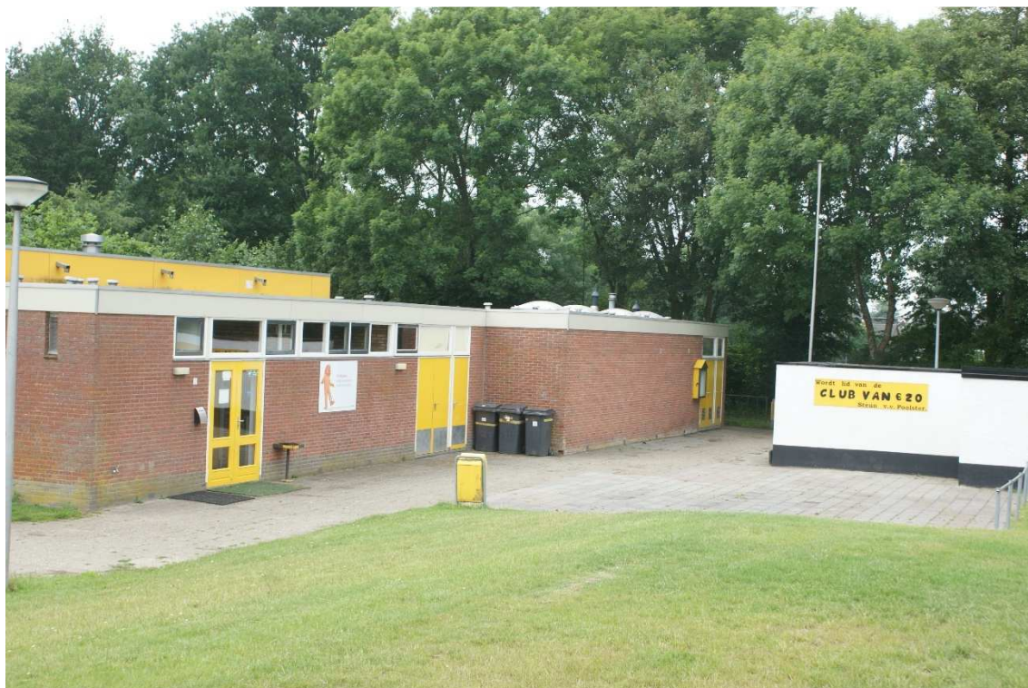
Figuur 2.2. Clubgebouw VV Poolster met op achtergrond bosschage
