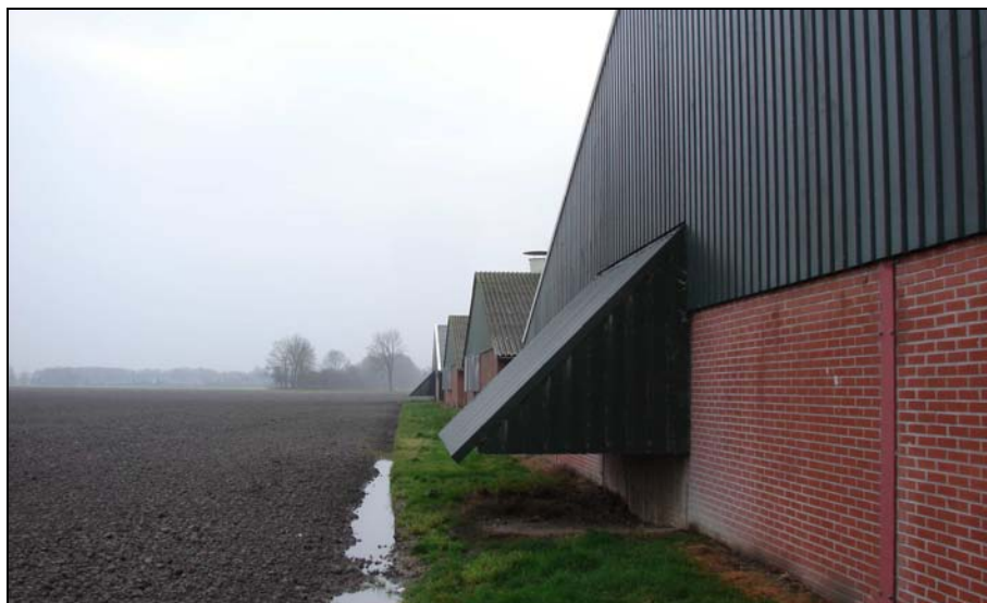
Situatie plangebied d.d. 2 februari 2012, achterzijde pluimveestallen
