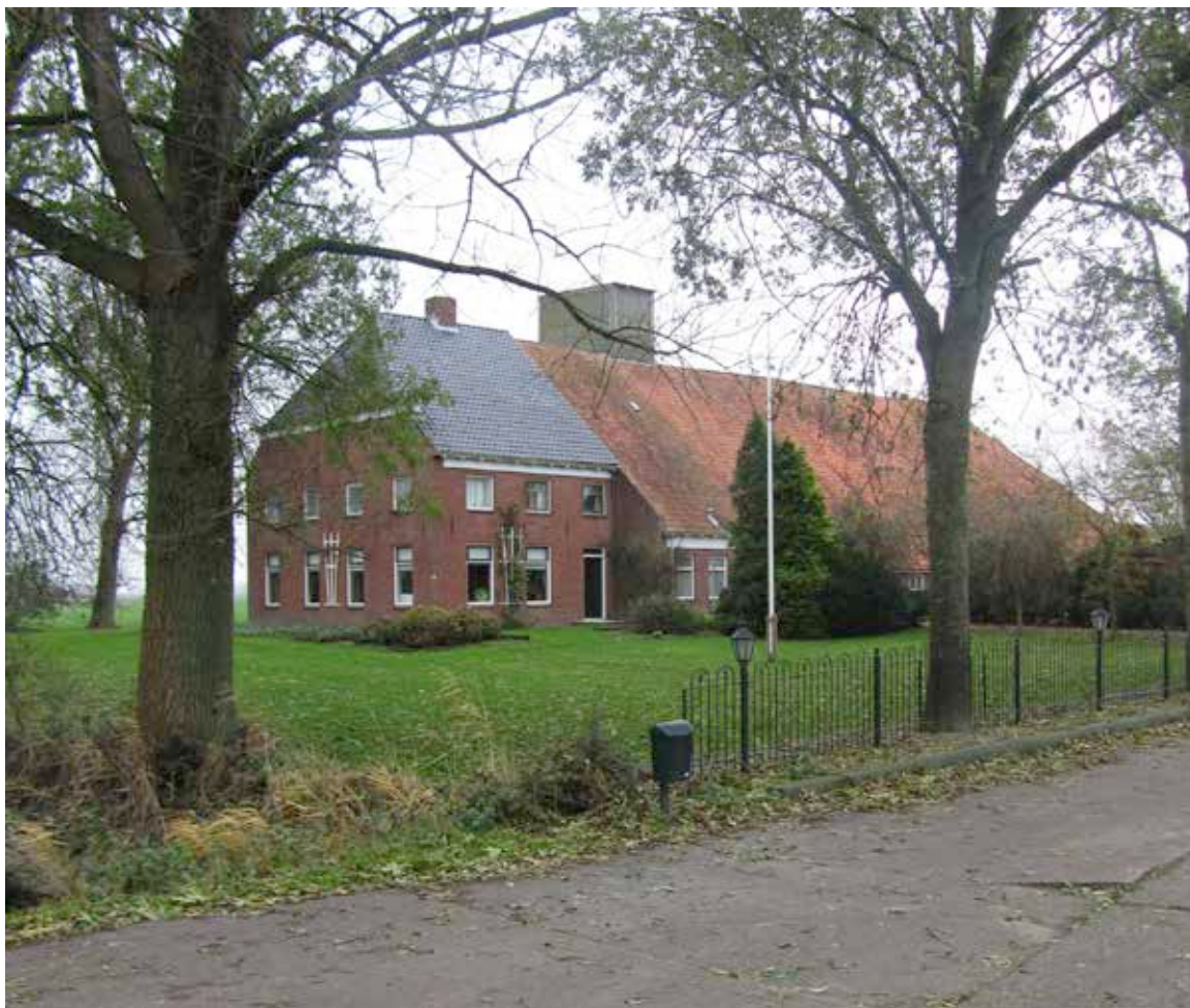
zicht op de boerderij vanaf de Meedhuizerweg vanuit het zuiden
