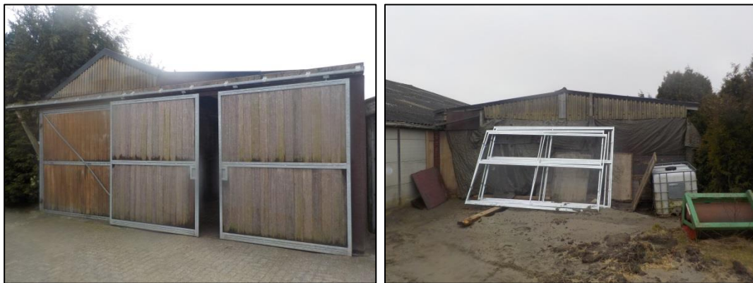
Foto 2 Impressie van de te slopen stal. Linker foto de voorzijde en rechterfoto de achterzijde.
