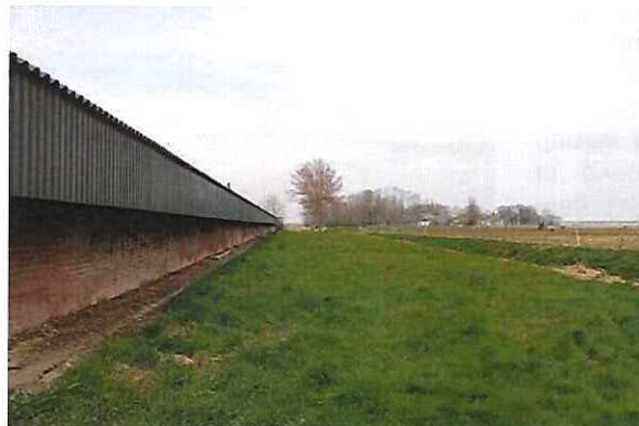
oostelijke erfgrens in noordelijke richting
