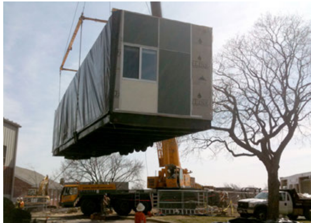
prefabricage van lichte elementen en positionering op fundering
