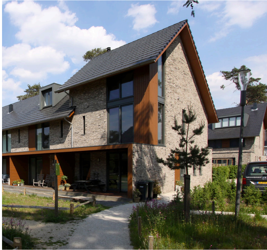
Kerckebosch Zeist, Verandawoningen | MIX Architectuur
