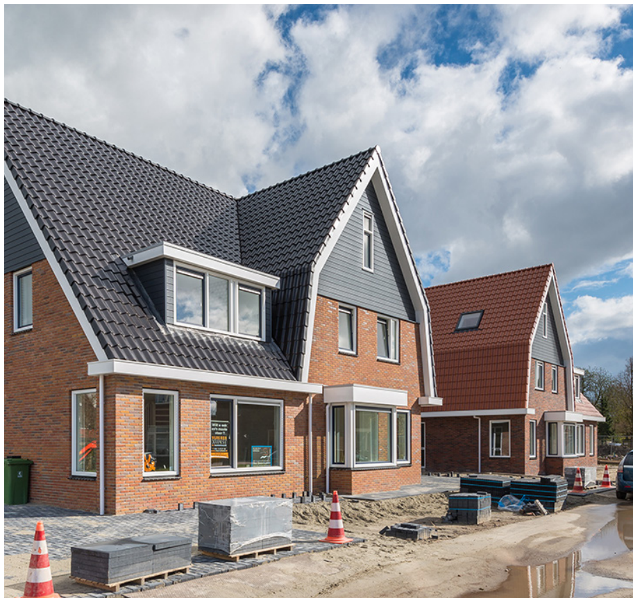
Willem Alexanderlaan, Appingedam | kleinschalige bebouwing
