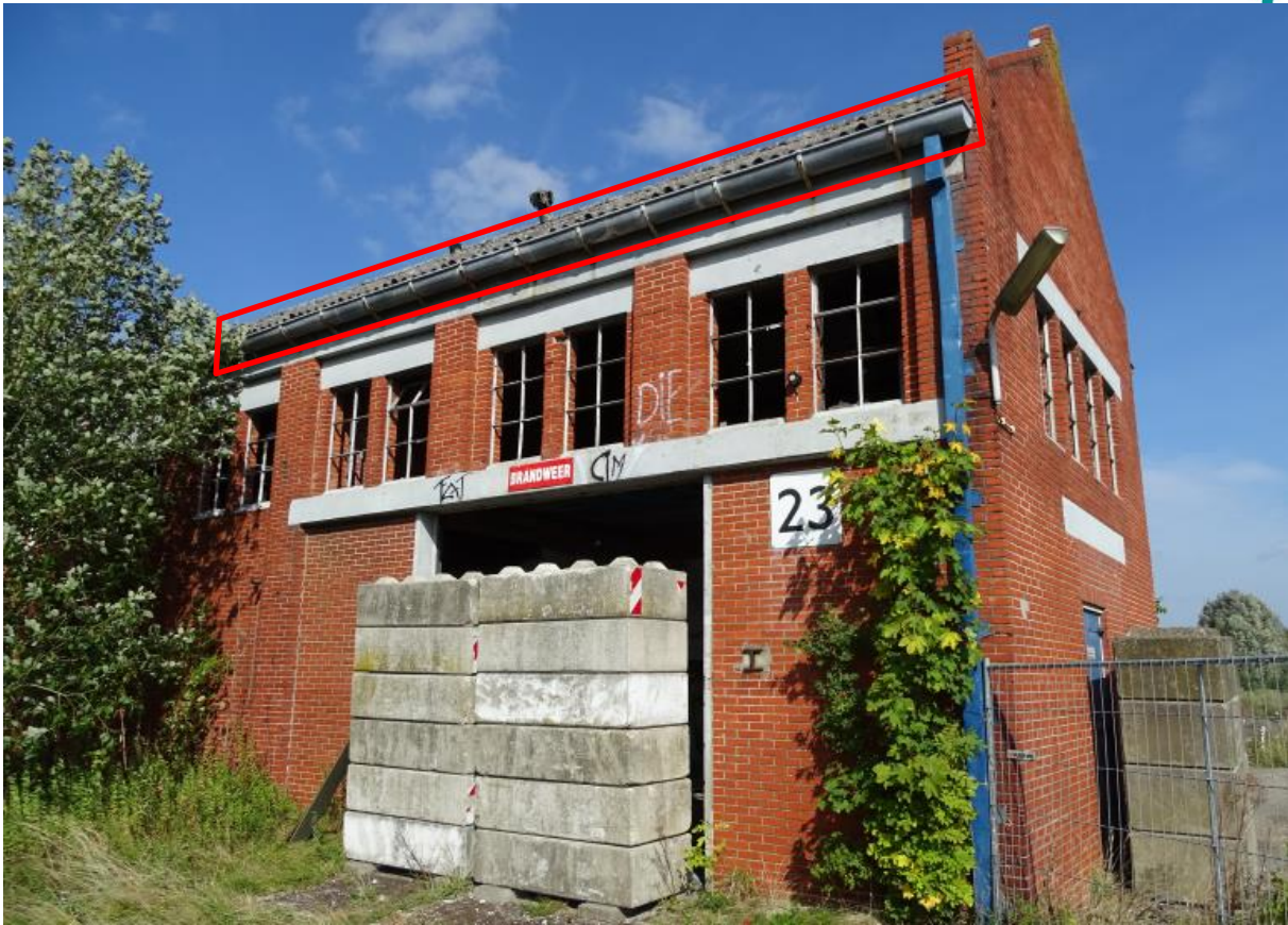
Figuur 5.1. Loods 23, potentieel geschikte nestplaats voor huismussen onder de dakpannen (rood omrand).
