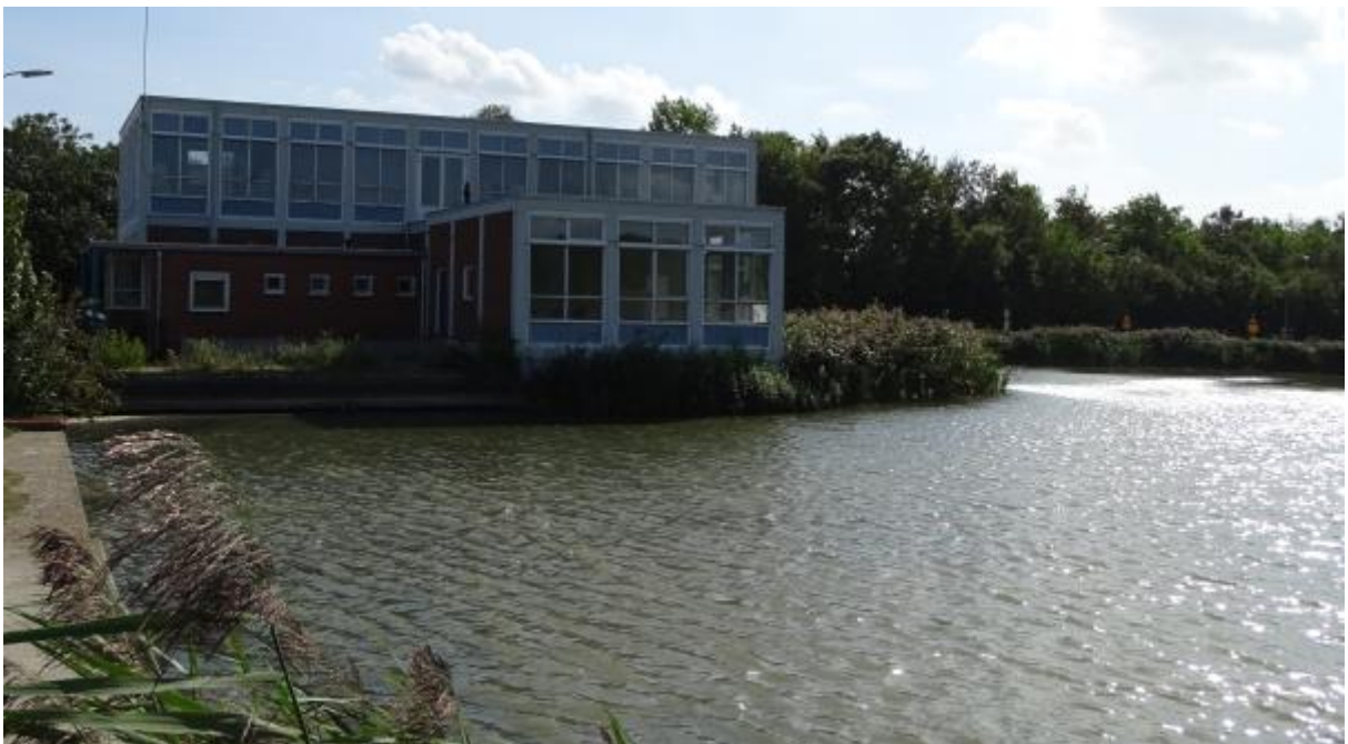
Figuur 2.5. Voormalig kantoorpand van De Eendracht, gelegen in het oosten van de onderzoekslocatie.
