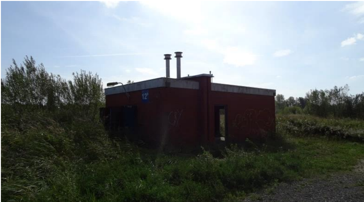
Figuur 2.4. Voormalige loods 12b, gelegen in het westen van de onderzoekslocatie.
