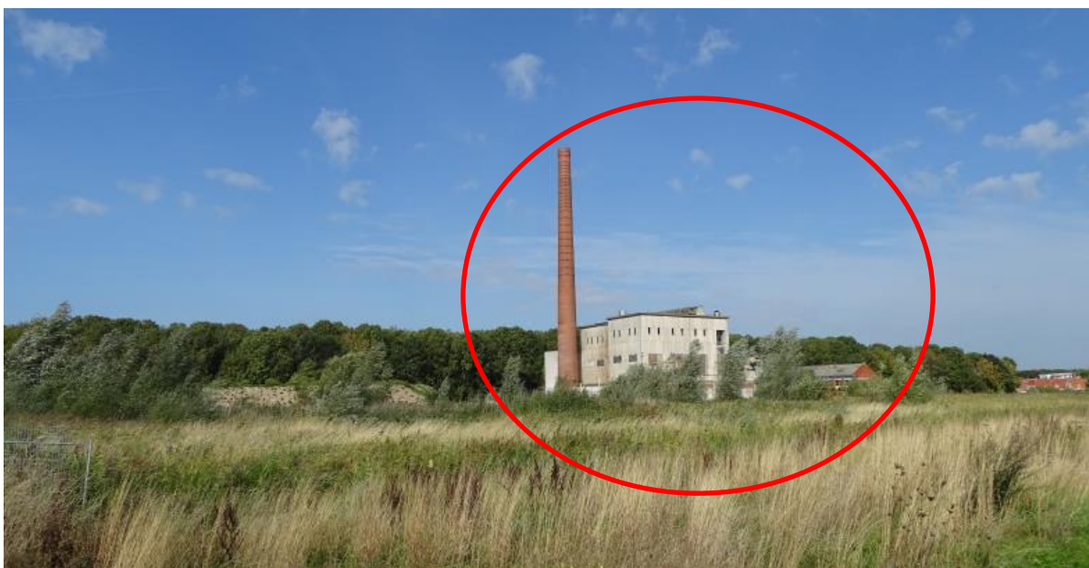
Figuur 2.3. Overzichtsfoto voormalige fabriek, loods 12, loods 23 (rood omcirkeld) en verruigde omgeving, gelegen in het westen van de onderzoekslocatie.
