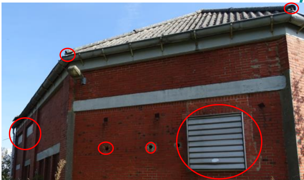
Figuur 5.7. Achterzijde van loods 23, toegangsmogelijkheden naar potentiële verblijfplaatsen (rood omcirkeld).
