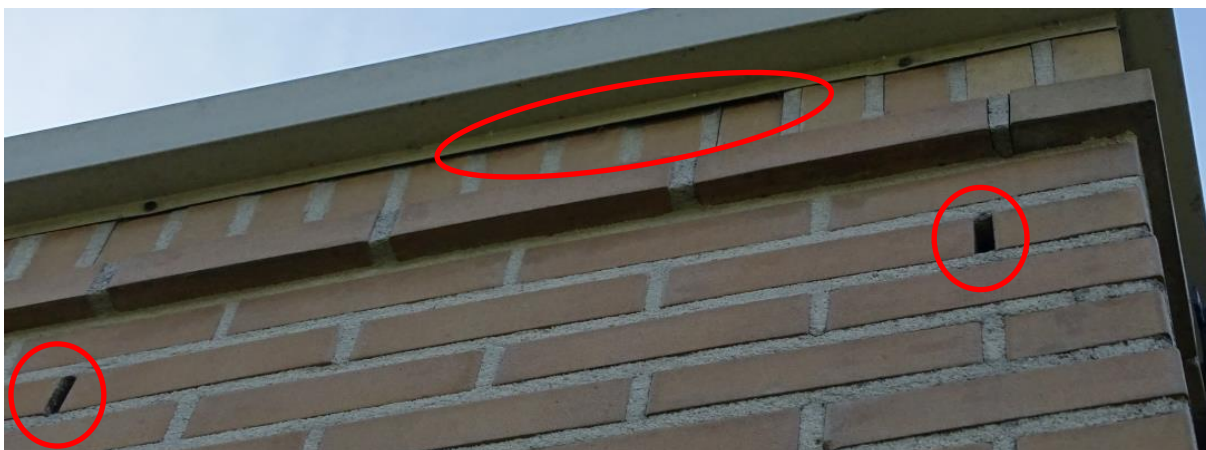
Figuur 5.9. Open stootvoegen en ruimte onder de dakrand, toegangsmogelijkheden naar potentiële verblijfplaatsen.
