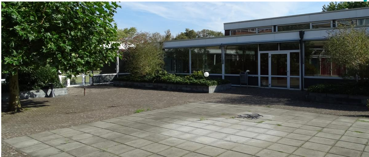
Figuur 2.16. Overzichtsfoto van het binnenplein, bevindt zich in de midden van de onderzoekslocatie.
