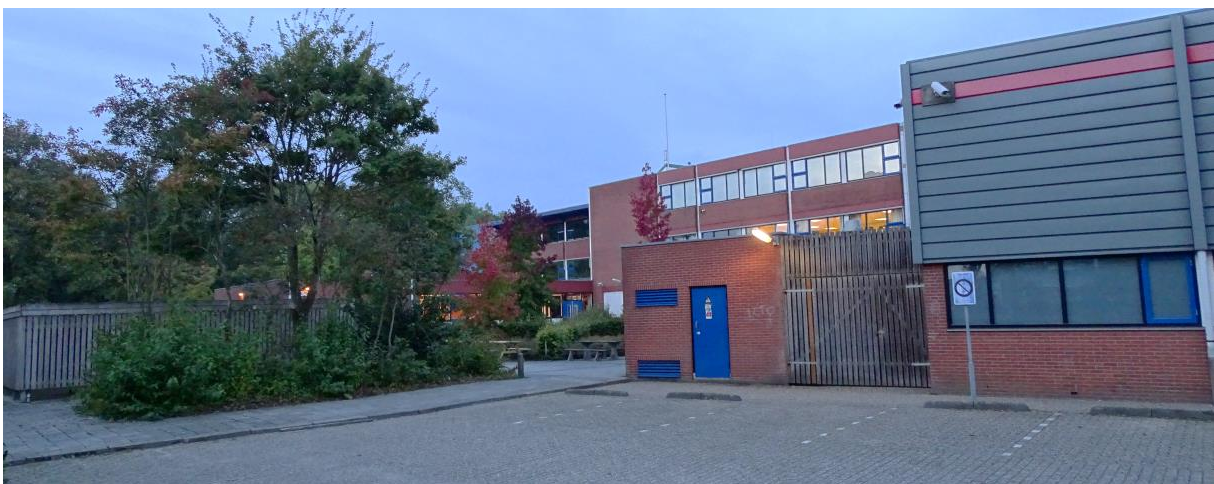
Figuur 2.5. Achterzijde van het schoolgebouw en gymlokaal, gezien vanaf de parkeerplaats aan de achterzijde.
