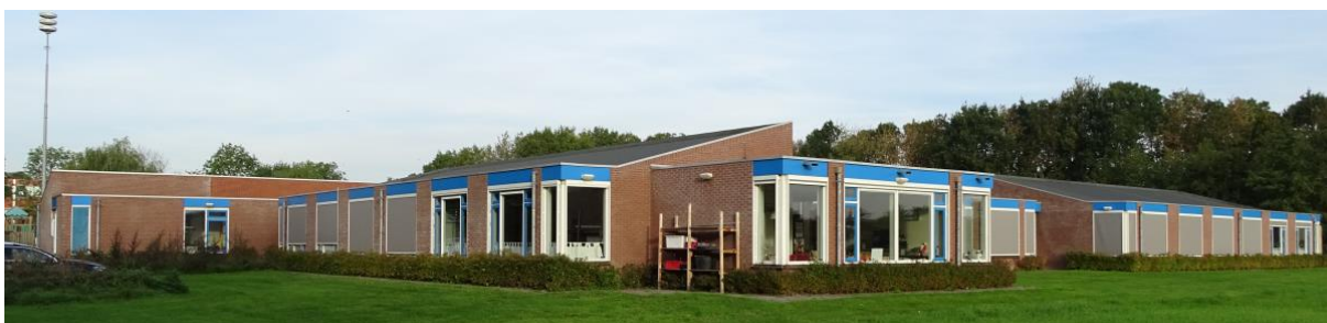
Figuur 2.8. Overzichtsfoto achterzijde van het schoolgebouw, gezien vanuit oostelijk richting.
