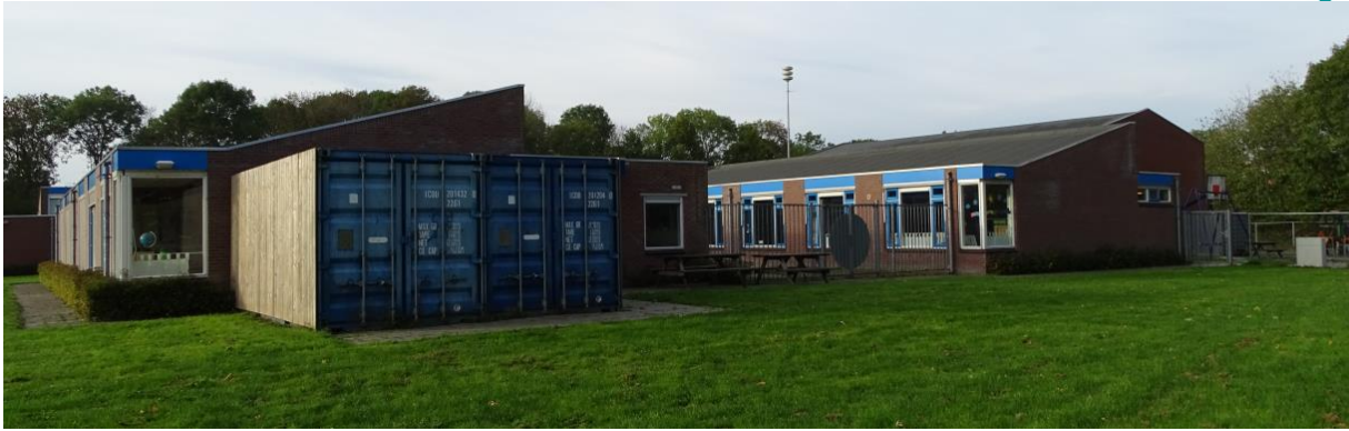
Figuur 2.9. Zijaanzicht van het schoolgebouw, gezien vanuit noordelijke richting.
