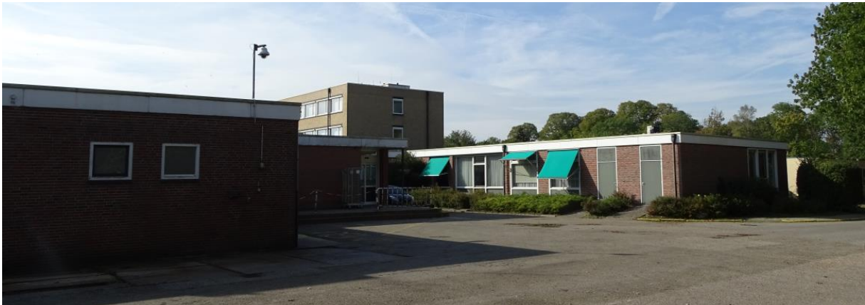
Figuur 2.15. Overzichtsfoto van de achterzijde van de onderzoekslocatie, gezien vanuit het noorden.
