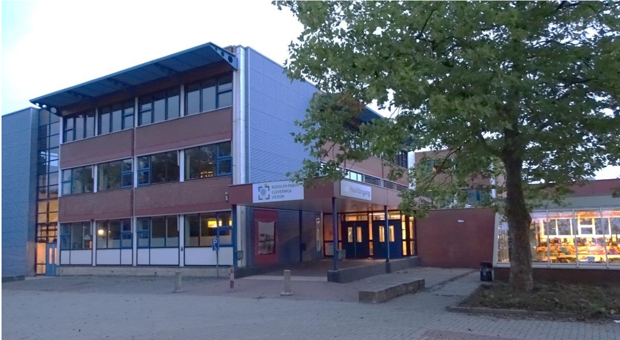
Figuur 2.3. Hoofdingang van het schoolgebouw gezien vanaf de parkeerplaats aan de voorzijde.
