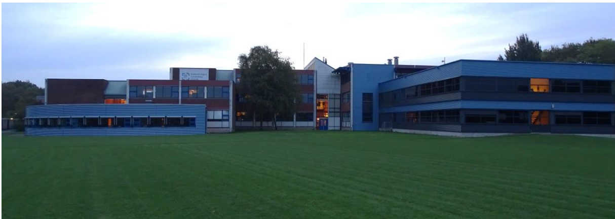
Figuur 2.4. Overzichtsfoto van het schoolgebouw gezien vanaf het sportveld.
