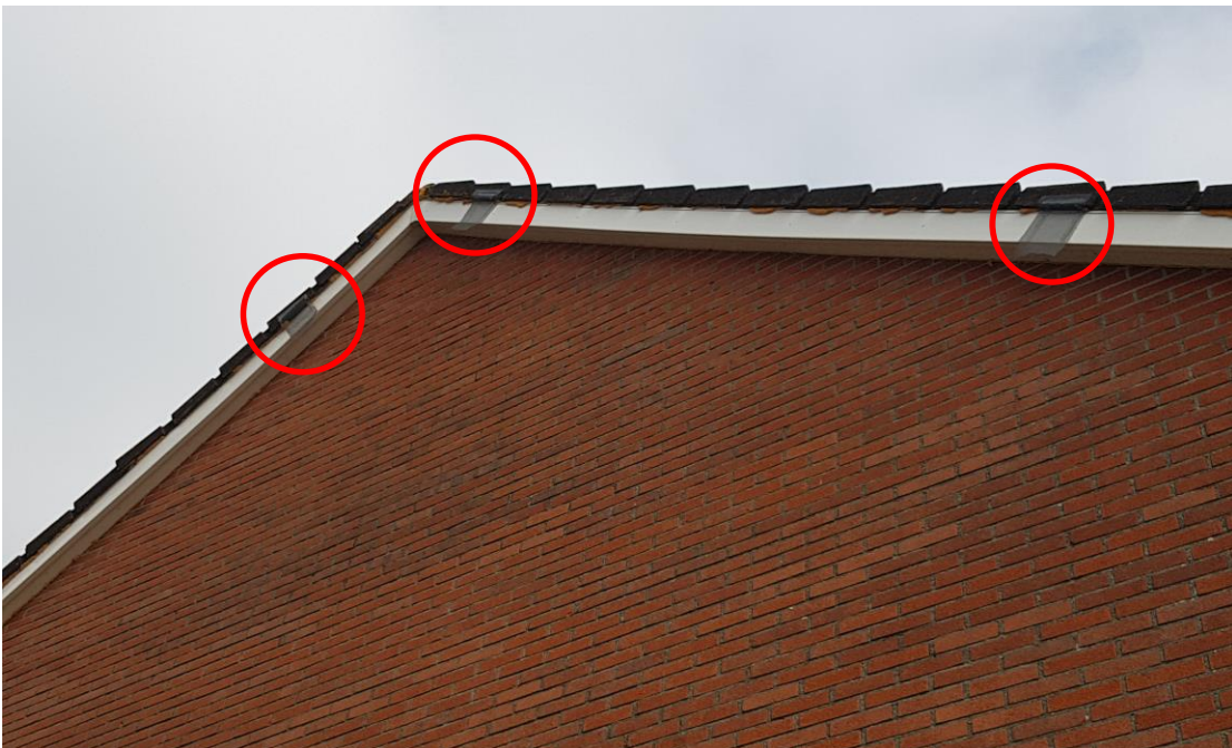
Figuur 2-4 Nokpannen aan de Burg. De Sitterstraat ontoegankelijk gemaakt middels pur en exclusion flaps (rood omcirkeld).
