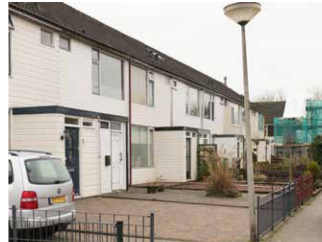
Boven: Kopgevel in huidige situatie Onder: Erkers in huidige situatie
