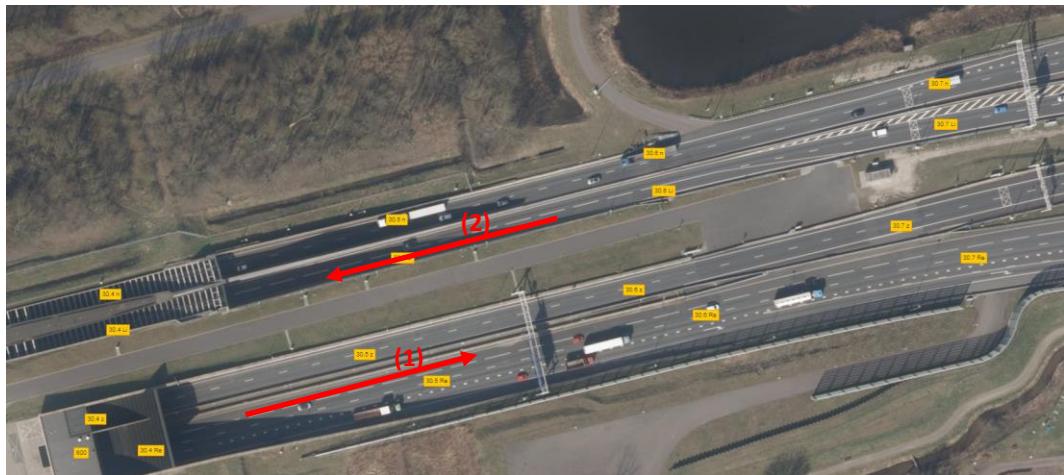
Figuur 104: Rijstroken in Coentunnel
