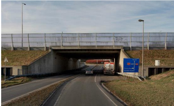
Figuur 24: bestaande onderdoorgang Laan der Continenten
