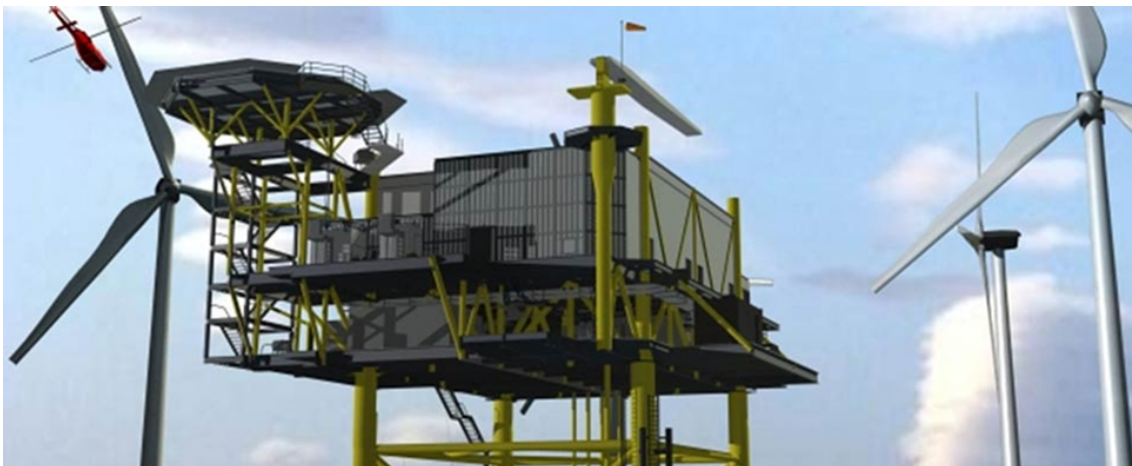
Figuur 8 Voorbeeld platform voor een transformatorstation
