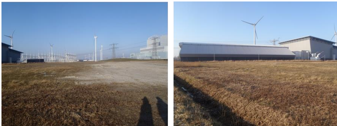
Figuur 12 Locatie converterstation (foto's gemaakt tijdens veldbezoek op 19 februari 2015)
