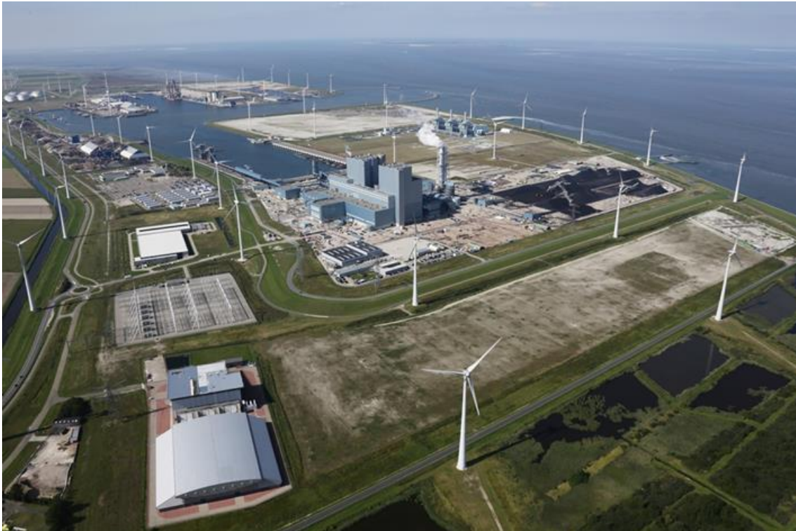
Afbeelding 4: Het convertorstation van de NorNed-kabel (linksonder) en de landschappelijke inpassing in het industriële landschap met daarnaast de geplande locatie van het COBRACable convertorstation (rode stippellijn).
