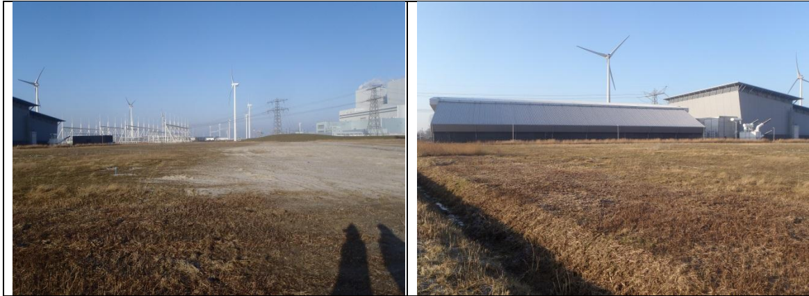
Afbeelding 10: Locatie convertorstation oostlob Eemshaven (foto's gemaakt tijdens veldbezoek 19 februari 2015).
