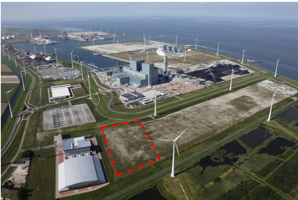
Figuur 5 Het converterstation van de NorNedkabel (linksonder) en de landschappelijke inpassing in het industriële landschap met daarnaast de geplande locatie van het COBRACable converterstation (rode stippellijn)
