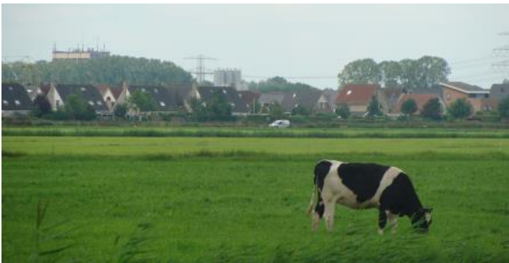
Foto 8: Bestaande 220 kV-verbinding door Bedum
