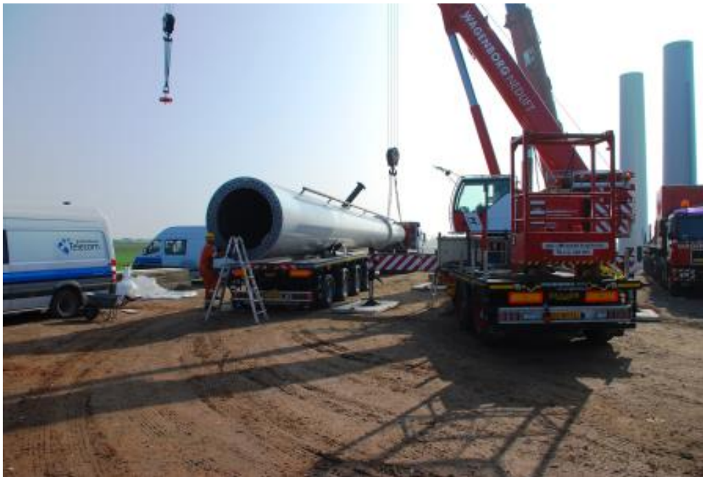
Foto 17: Assemblage mast
