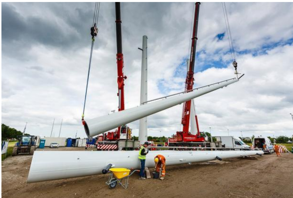
Foto 6: plaatsing van een Wintrackmast
