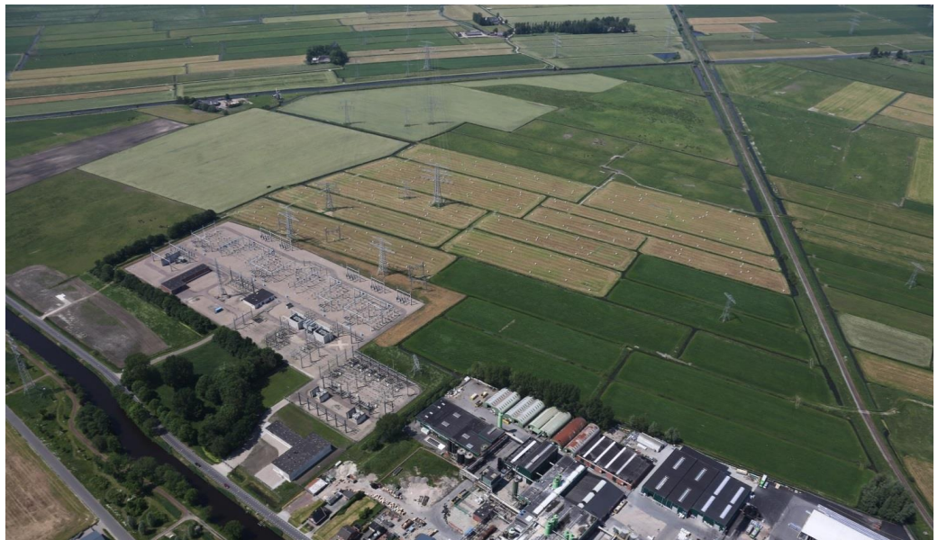
Foto 4: Bedrijventerrein Westpoort met transformatorstation Vierverlaten
