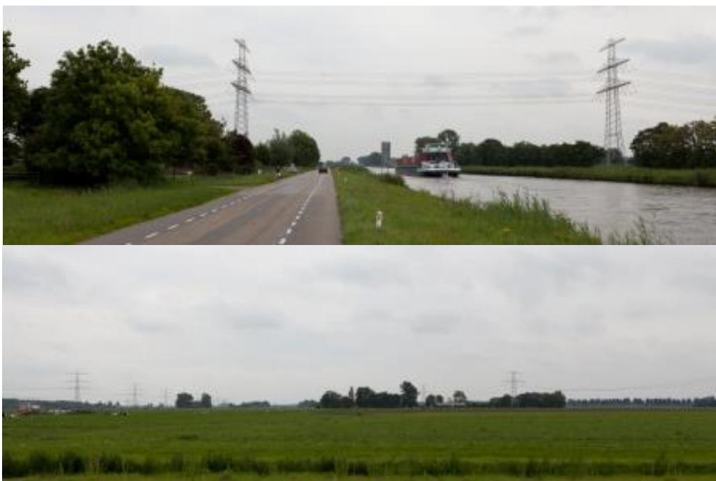
Foto 12: Aduarderdiep met bestaande 110 en 220 kV-verbindingen
