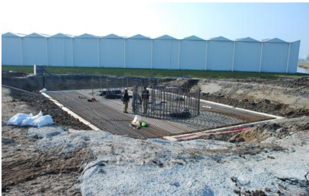
Foto 16: Aanbrengen bewapening
