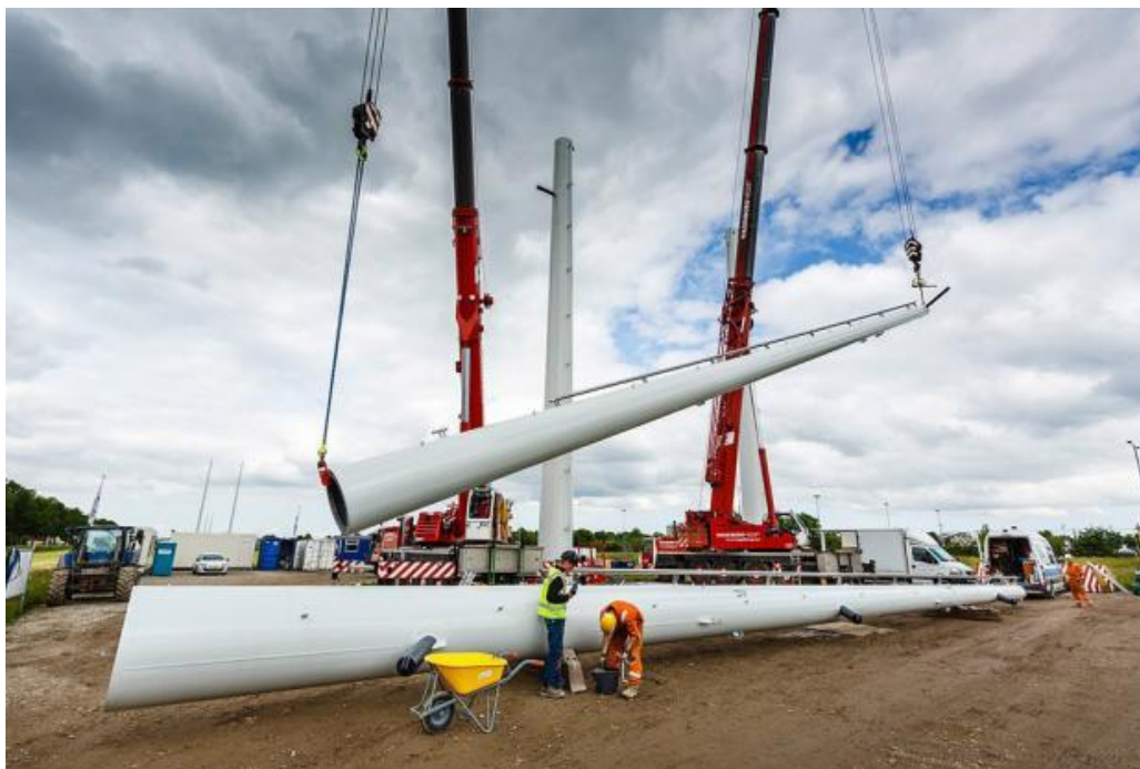
Foto 6: plaatsing van een Wintrackmast
