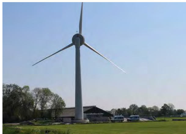
fig 10) De EWT DW 54, in Nieuwe Niedorp op een extreem lage mast van 35 meter. Zie ook schema figuur 4)
