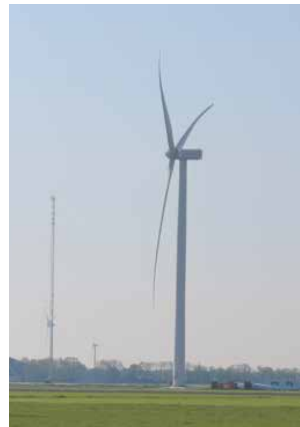
fig 7) GE 2.75-120. Tiplaagte 25 meter
