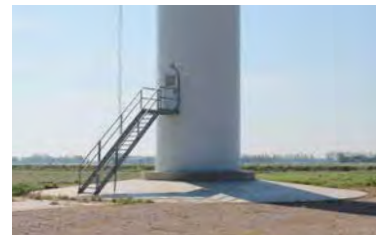
Voorbeeld oplopende betonnen mastvoet in de Wieringermeer
