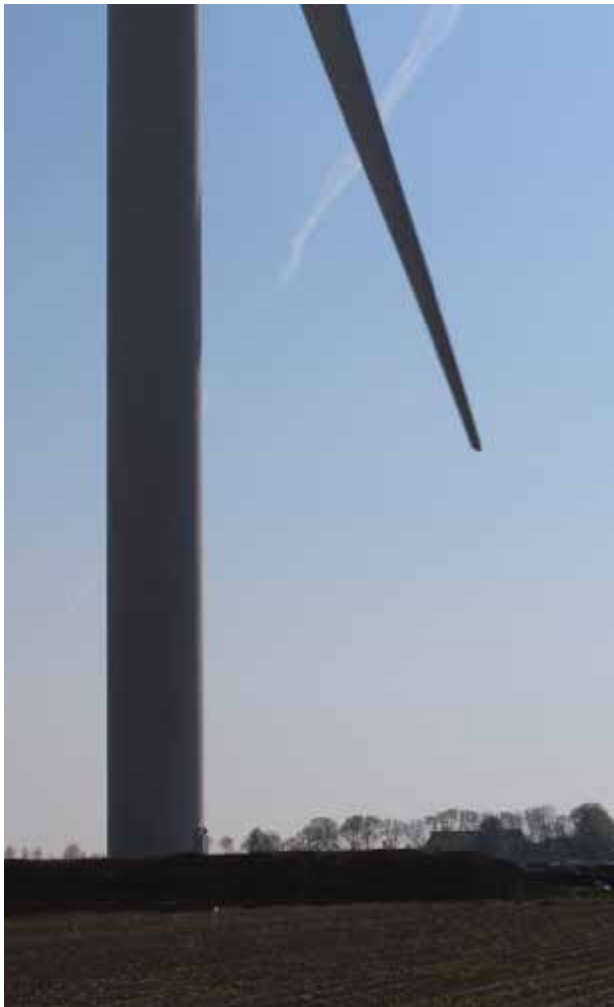
fig 8) Siemens SWT 3.6; Tiplaagte 20 meter
