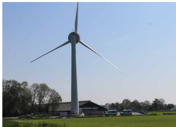
fig 10) De EWT DW 54, in Nieuwe Niedorp op een extreem lage mast van 35 meter. Zie ook schema figuur 4)
