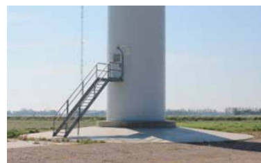
Voorbeeld oplopende betonnen mastvoet in de Wieringermeer
