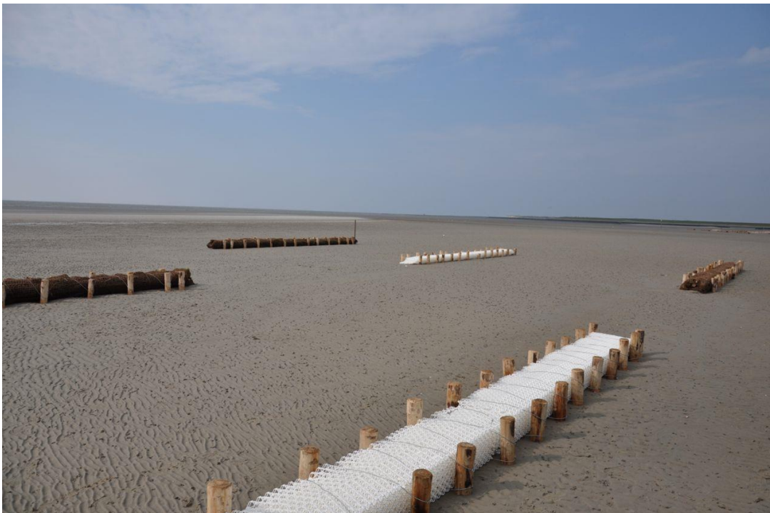
Figuur 5. BESE-elements toegepast in de Waddenzee, ten behoeve van herstel mosselbanken
