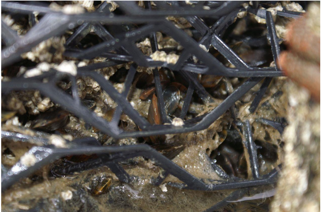
Figuur 6. Detail BESE-elements, met mosselbroed
