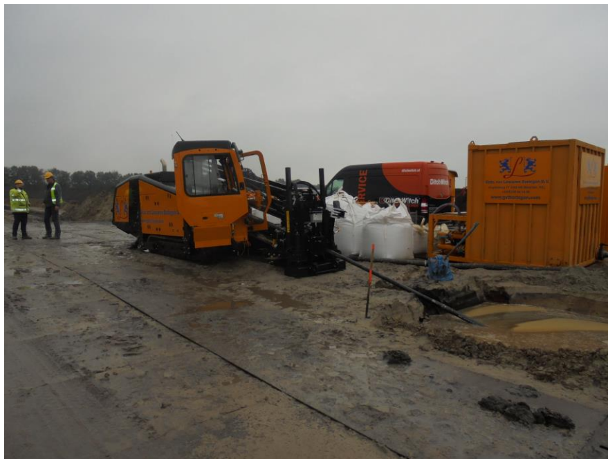
Foto 1: Booropstelling ten behoeve van een gestuurde boring
